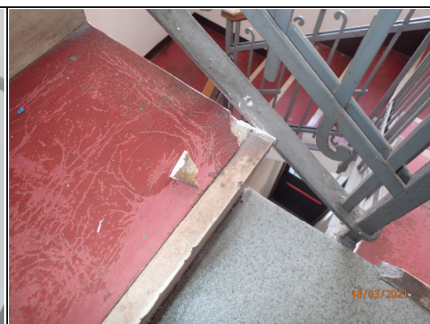
Figura 2.15: scale - pavimentazione vinilica gradini senza amianto
