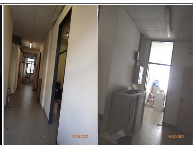
Figura 2.7: piano rialzato - controsoffitti in pannelli tipo Armstrong
