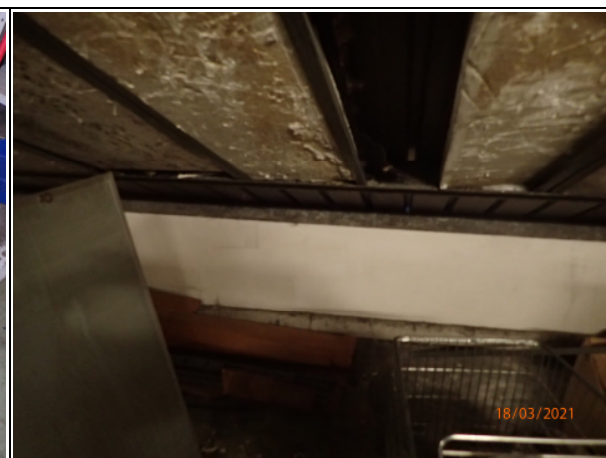
Figura 2.13: piano secondo, sottotetto - tubazione calore senza amianto
