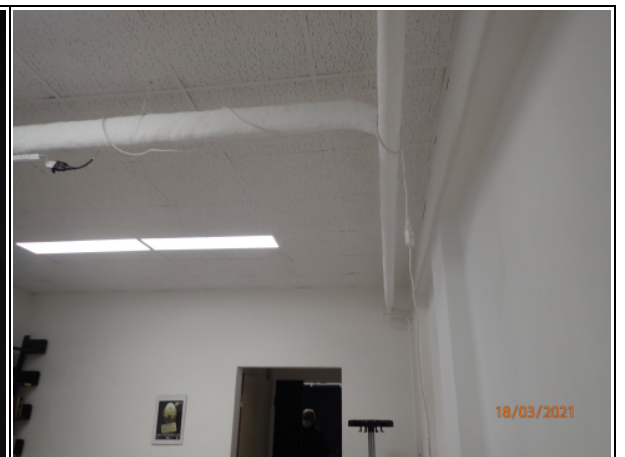
Figura 2.4 - piano seminterrato controsoffitto in pannelli tipo Armstrong
