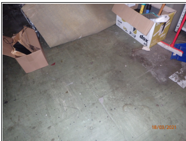
Figura 2.12: piano secondo, sottotetto pavimentazione vinilica senza amianto
