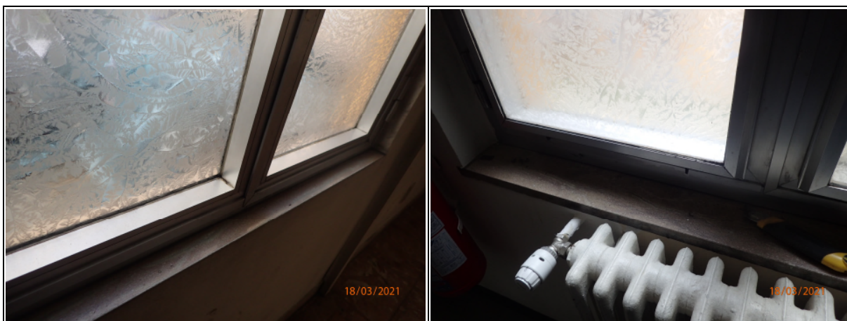
Figura 2.9: piano primo - ferma vetri in gomma su infissi in alluminio
