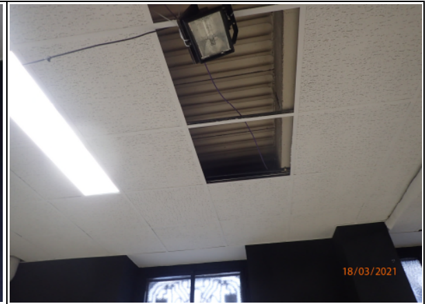
Figura 2.4 - piano seminterrato controsoffitto in pannelli tipo Armstrong
