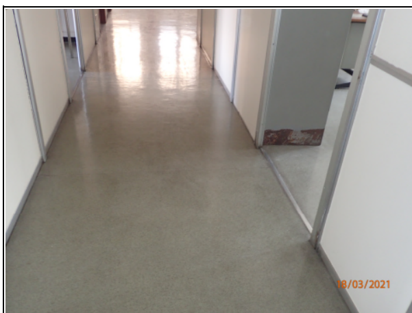
Figura 2.14: piano secondo - pavimentazione vinilica senza amianto
