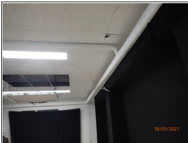
Figura 2.5: piano seminterrato - tubazione calore
