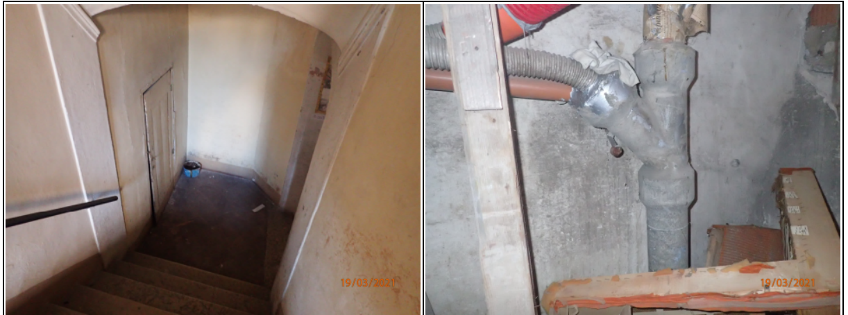
Figura 2.4: cavedio tra primo e secondo piano – canale in fibrocemento
