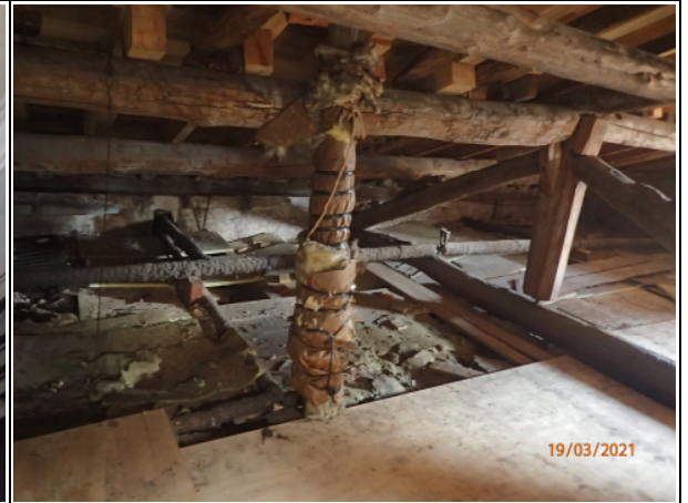
Figura 2.6: piano sottotetto – materassino in FAV
