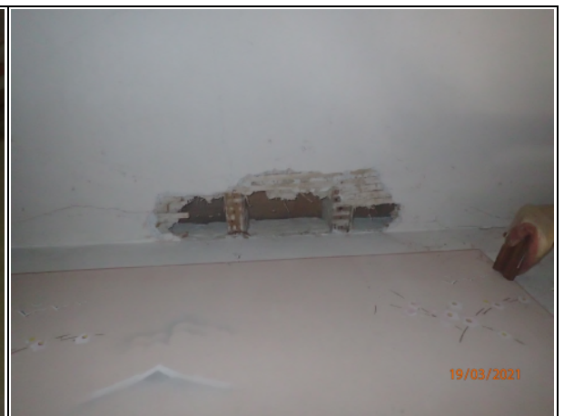
Figura 2.2: locale CT - canale in fibrocemento
