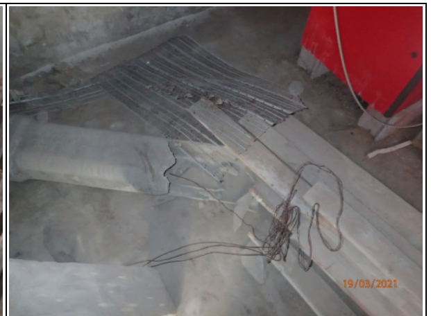
Figura 2.2: locale CT - canale in fibrocemento
